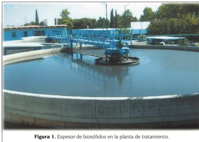
**Figura 1.** Espesor de biosólidos en la planta de tratamiento.
